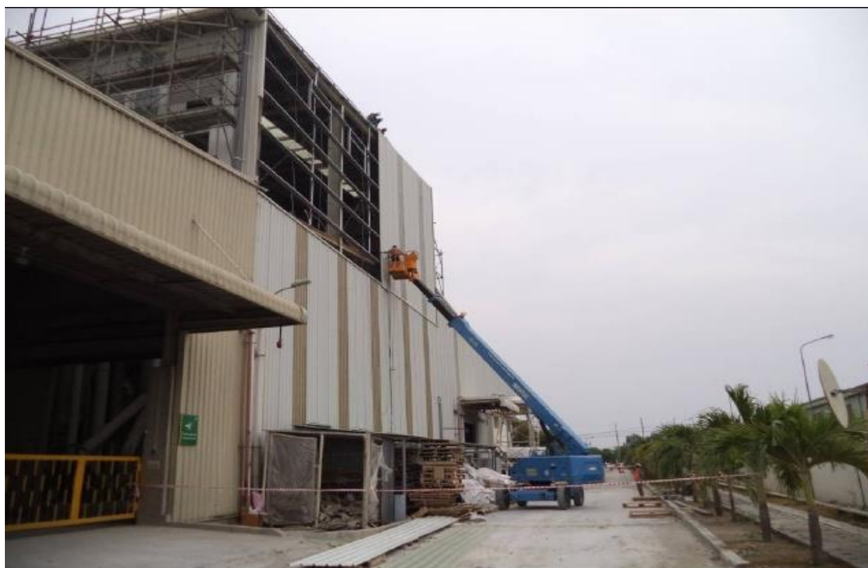
XE NÂNG BOOM LIFT ĐỂ LẮP ĐẶT KẾT CẤU THÉP
