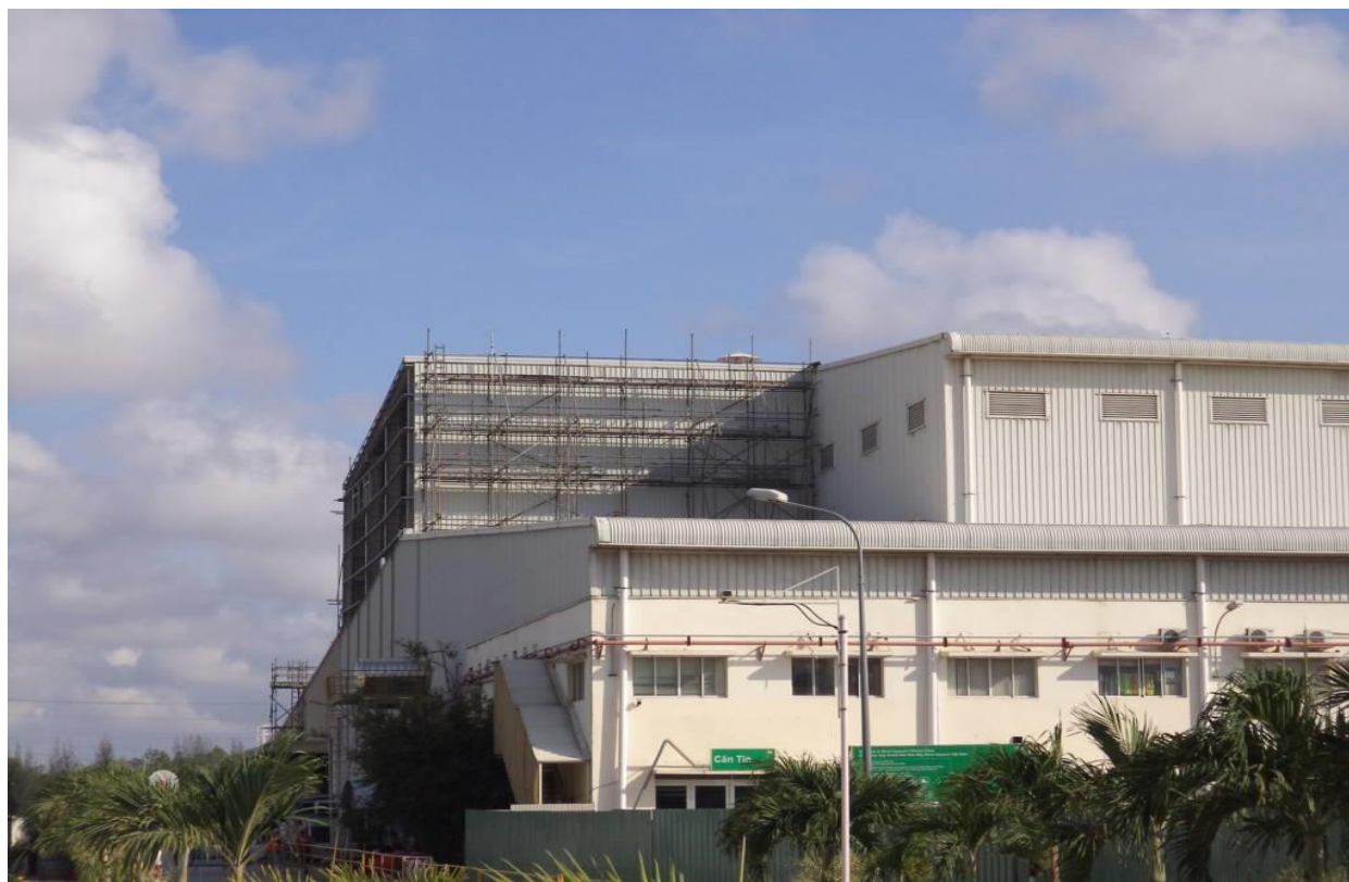
NÂNG CẤP KẾT CẤU THÉP MÁI NHÀ XƯỞNG TỪ 13M LÊN 21M
