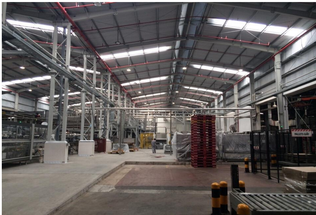
NÂNG CẤP KẾT CẤU THÉP MÁI TỪ 6M LÊN 9M
