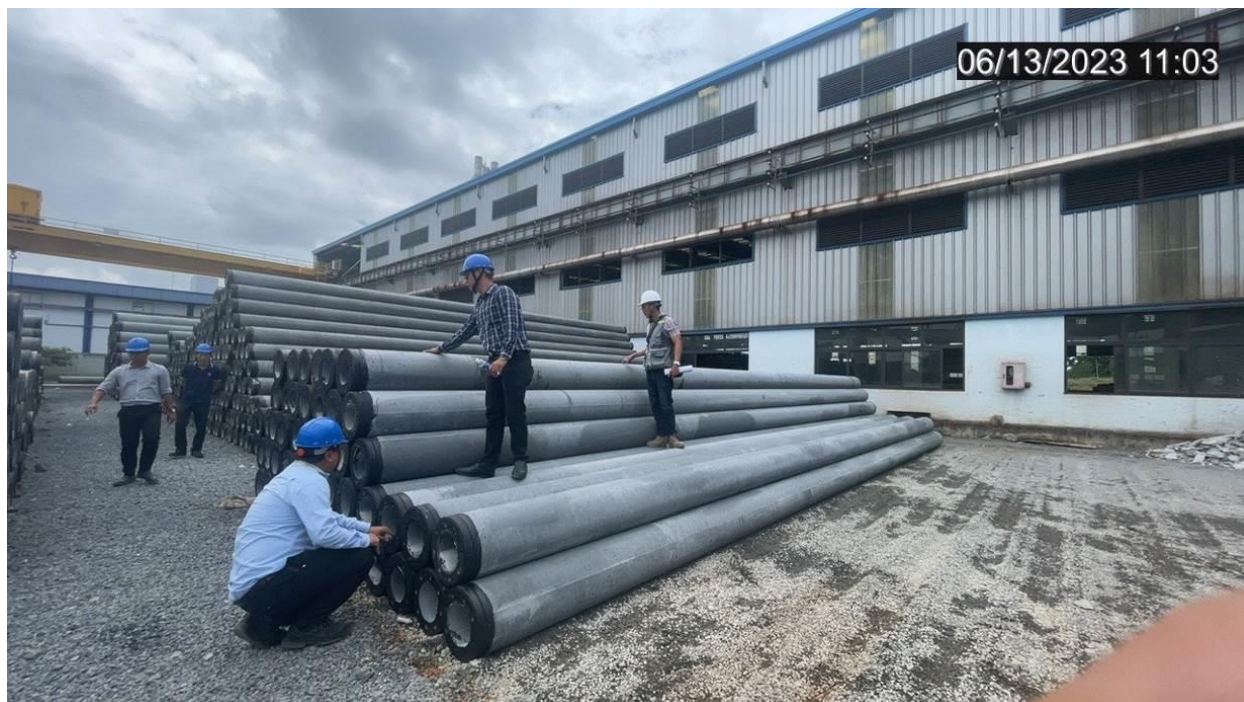
NGHIỆM THU SẢN XUẤT CỌC TẠI NHÀ MÁY INSPECTION OF PRODUCTION PILE AT FACTORY
