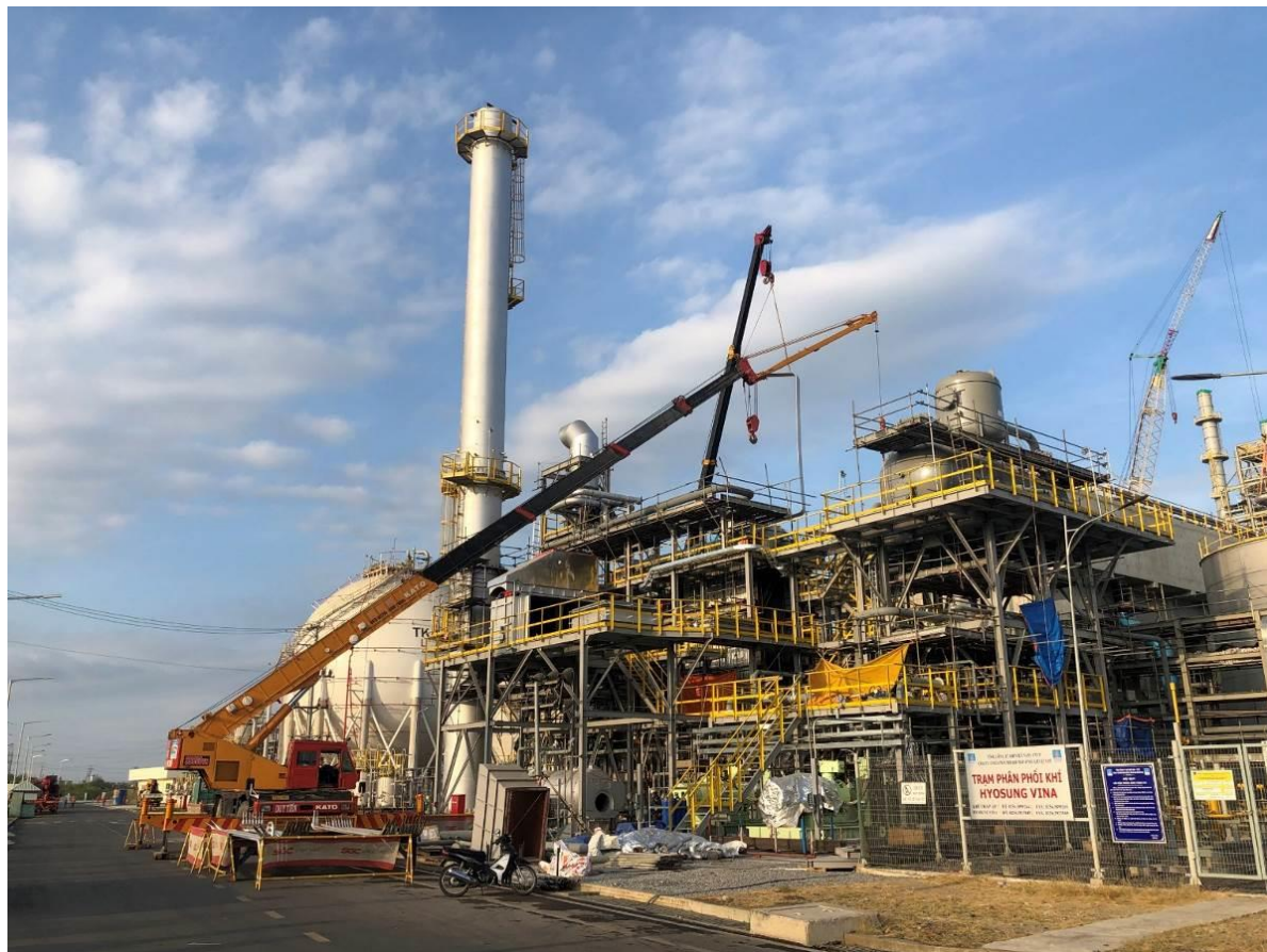
HẠNG MỤC: LÒ HƠI, ỐNG KHÓI, KẾT CẤU THÉP, ỐNG CÔNG NGHỆ
